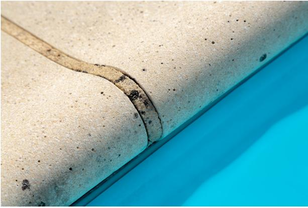
Figure 5: Cantilevered Pool Edge
